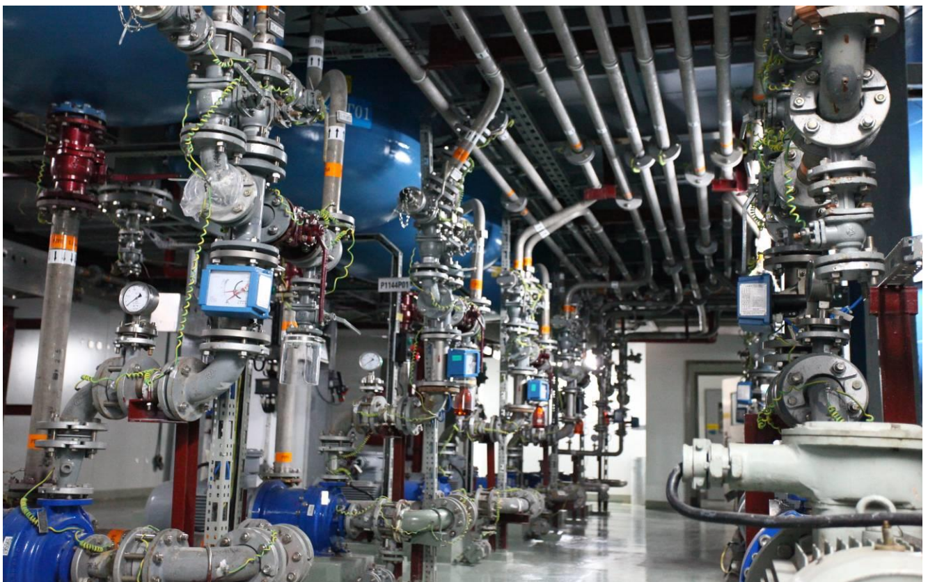
管线应用现场
