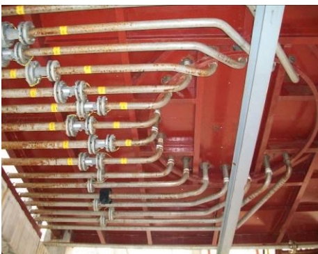
管线应用现场
